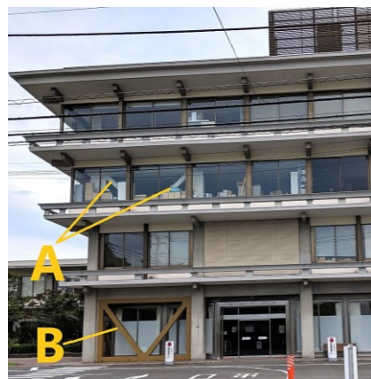
鎌倉市役所 現庁舎
